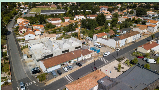
Avancement pendant les travaux
