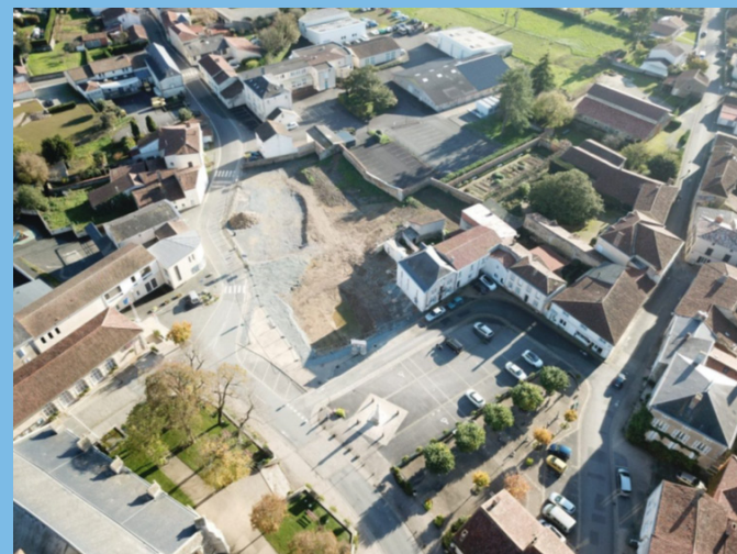
Coeur de bourg après démolition
