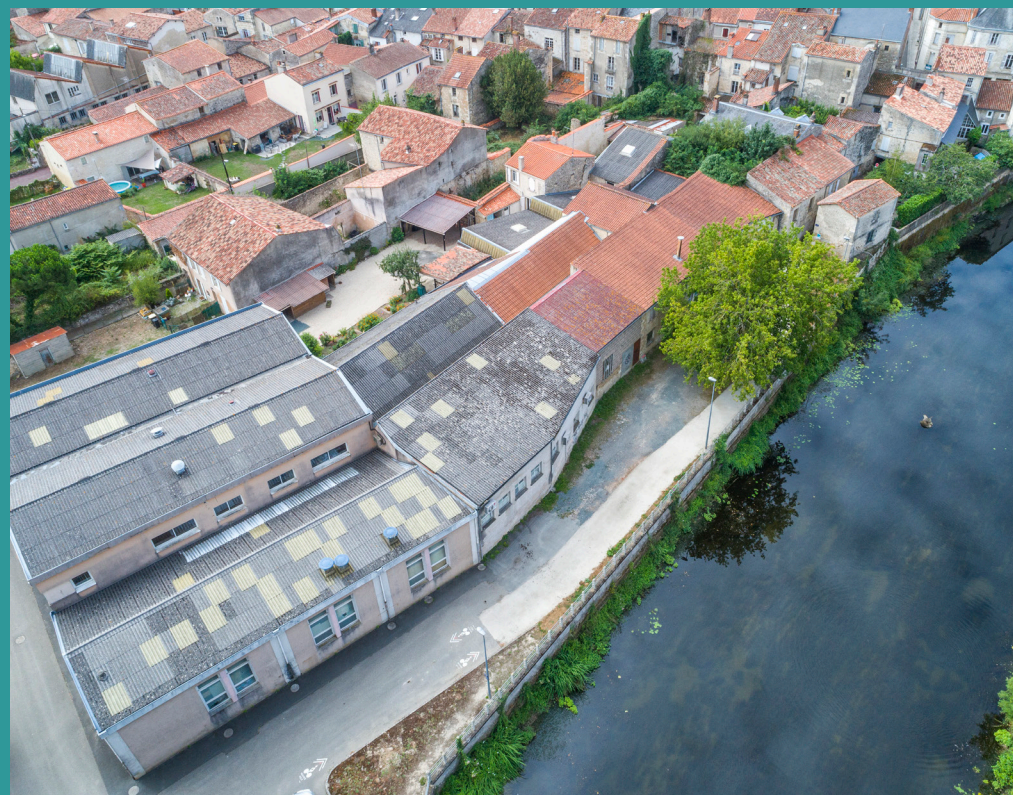
Imprimerie lussaud avant démolition
